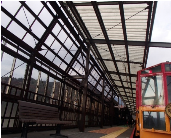
【トロッコ亀岡駅ホーム屋根改良】
