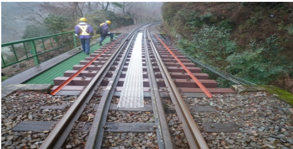
【トロッコ保津峡駅～トロッコ亀岡駅間】(7k672m 巖谷 B)
