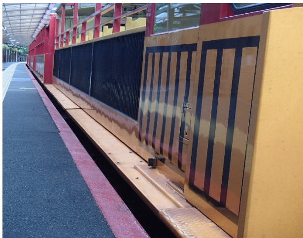
【車両転落防止用台ワクオオイ設置】
